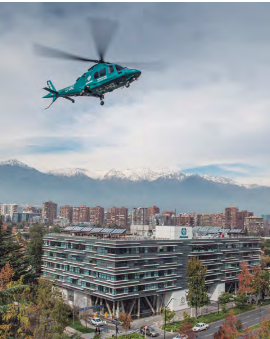
Edificio Manquehue Oriente.
